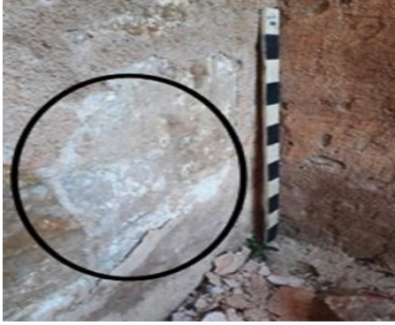
صورة رقم 05: انفصال طبقة الترميم
