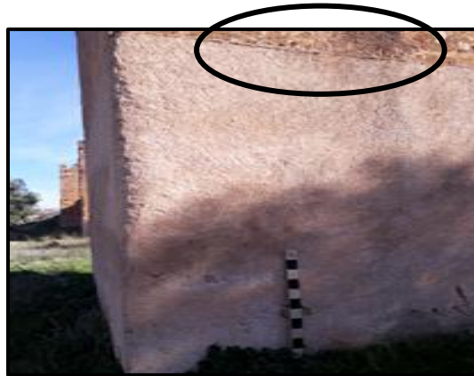
صورة رقم 06: عدم تجانس البنية
