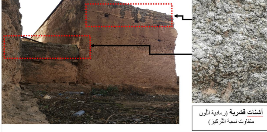
الصّورة (02): آثار الأضرار على الجدار الشّرقي من القصر، وجزء من سور حديقة.
