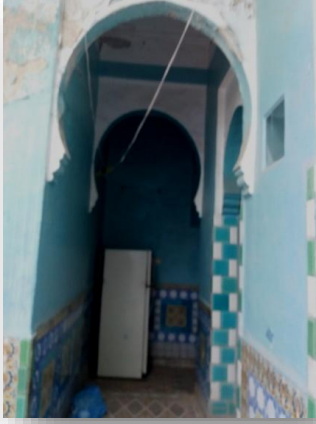
الصورة رقم (4): السقيفة المدخل المنكسر.
