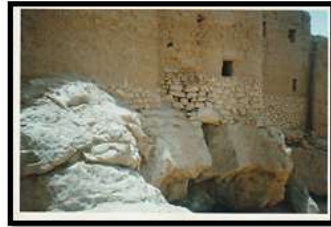
الصورة 25: تاغيت/ تقنية بناء الاسوار بالدش غير المنتظم وغير الموحد
