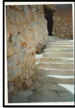
الصورة 23: تاغيت/ المدخل الرئيسي للقصر باب الشمال
