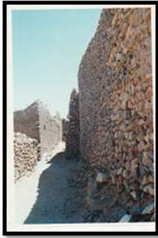
الصورة 26: تاغيت/ تقنية بناء الاسوار الخارجية بالدش غير المنتظم الموحد
