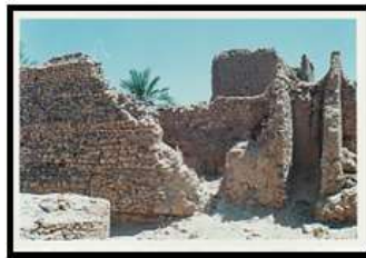
الصورة 27: القنادسة/ تقنية بناء الاسوار الخارجية بالدش المنتظم وغير الموحد
