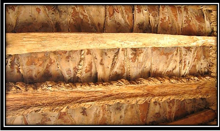
الصورة رقم: 3، توضح تقنية التسقيف بخشب النخيل والكرناف، من تصوير الباحث.
