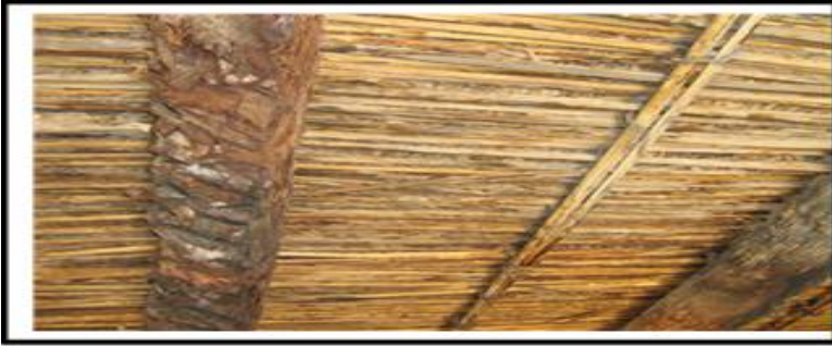
الصورة رقم (4): توضح تقنية التسقيف بخشب النخيل وعصي الجريد من تصوير الباحث.
