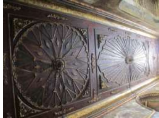
الصورة رقم 05: سقف جانبي لغرفة بقصر
