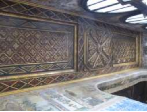
الصورة رقم 04: سقف غرفة
