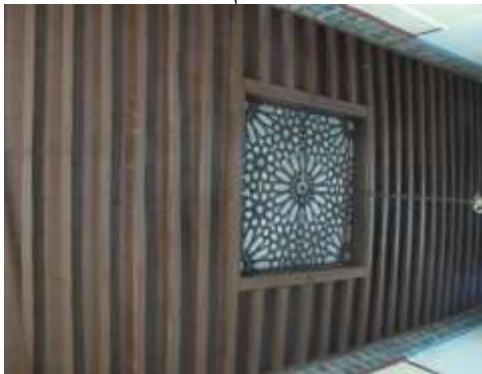
الصورة رقم 14: سقف غرفة
