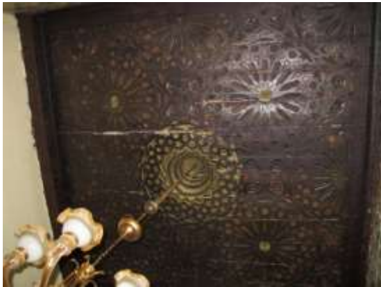
الصورة رقم 16: سقف غرفة
