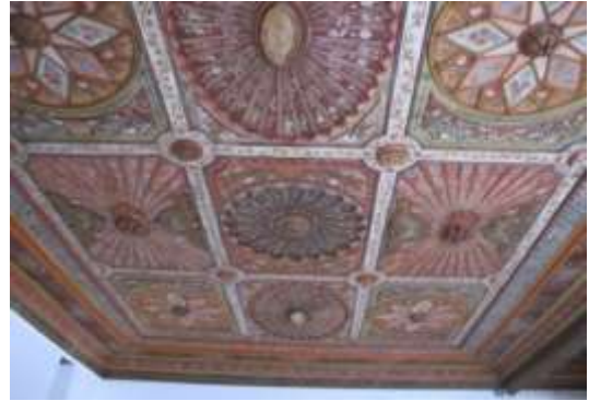
الصورة رقم 9: سقف غرفة الطعام بقصر 18 حصن 23 جانبي لغرفة الطعام
