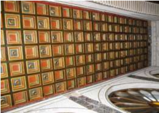
الصورة رقم 12: سقف غرفة
