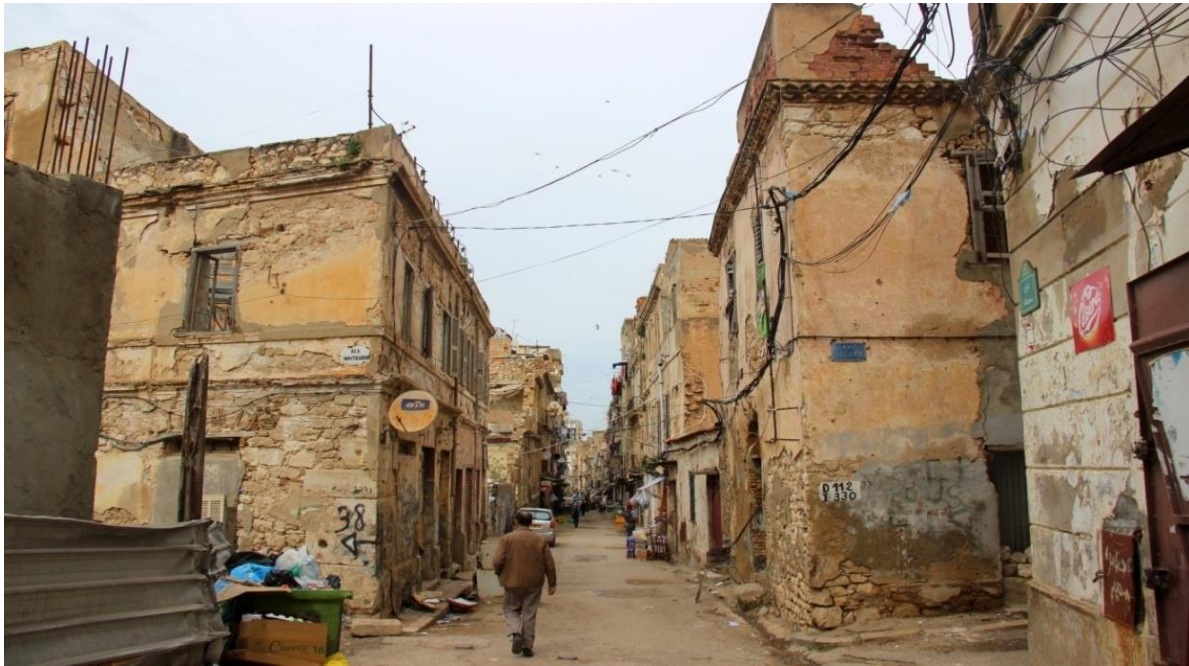
Photo.1 : état de la rue Dahou kada
