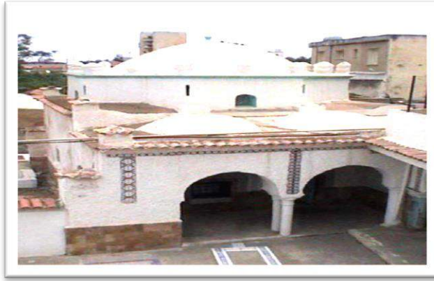
الصورة رقم 16 : الواجهة الرئيسية للضريح سيدي محمد الشريف بشرشال
