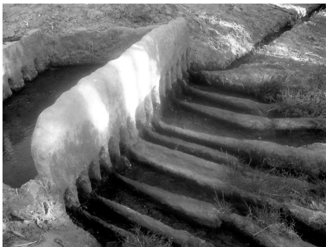
Fig. 5. Kasria secondaire de la foggara d'El Meghier Dans l'oasis de Timimoun (Remini, 2008)
