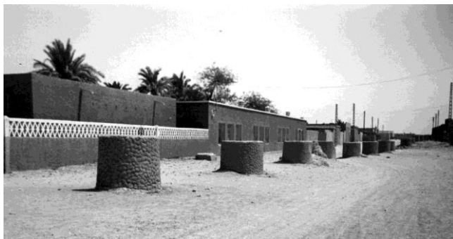
Fig. 4. Alignement des puits d'aération synonyme De la présence d'une galerie souterraine (Remini, 2002)
