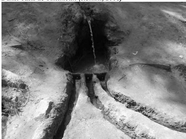
Fig. 6. Petite Kasria d'une foggara de l'oasis d'Ouled Said de Timimoun (Remini, 2008)
