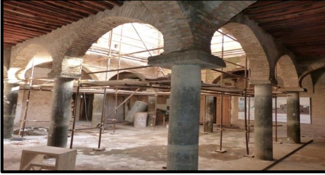
صورة رقم (04): الأعمدة الاسمنتية المضافة بقصر البايات.
