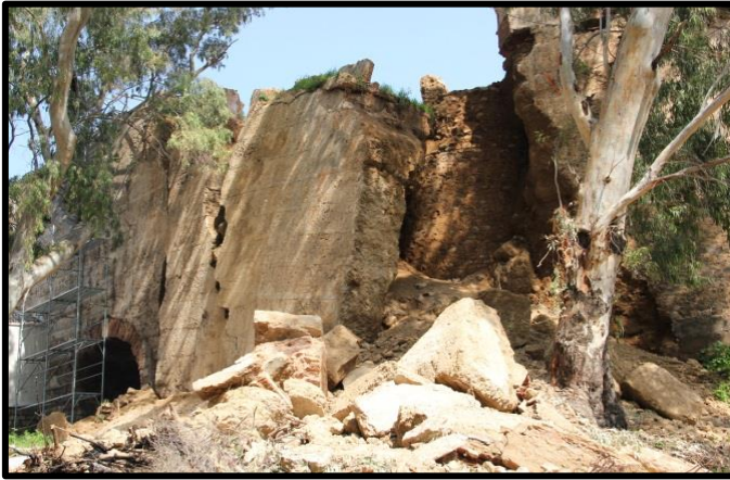
صورة رقم (05): انهيار جزء من السور الخارجي للقلعة. عن هاشمي سعدي
