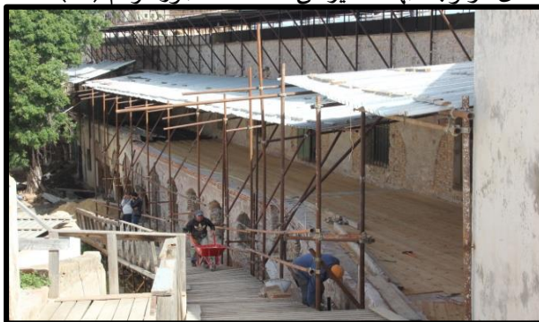
صورة رقم (09) : إعادة ترميم المخازن بالقلعة وتسقيفها
