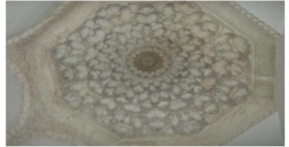
صورة رقم (6): السقف الخشبي لمسجد سيدي أبي الحسن
