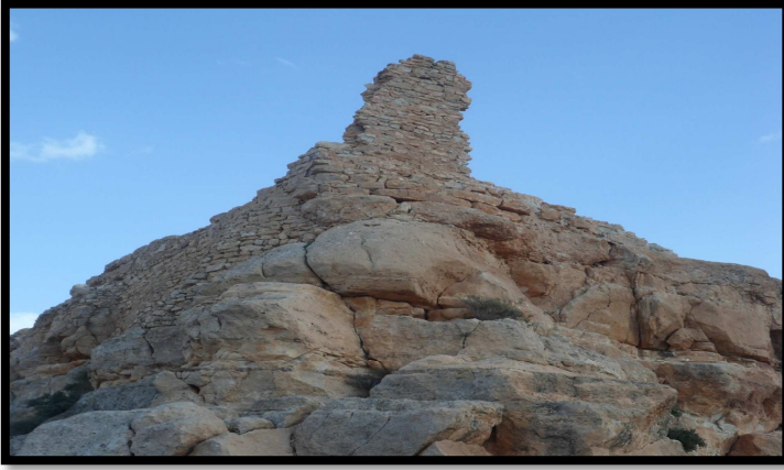
الشكل رقم 7. منظر جانبي لبرج المراقبة
