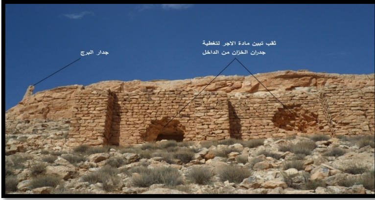
شكل رقم 13. جدران الخزان
