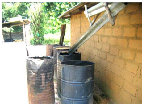
Photo1 : collecte de l'eau dans des tonneaux en fer
