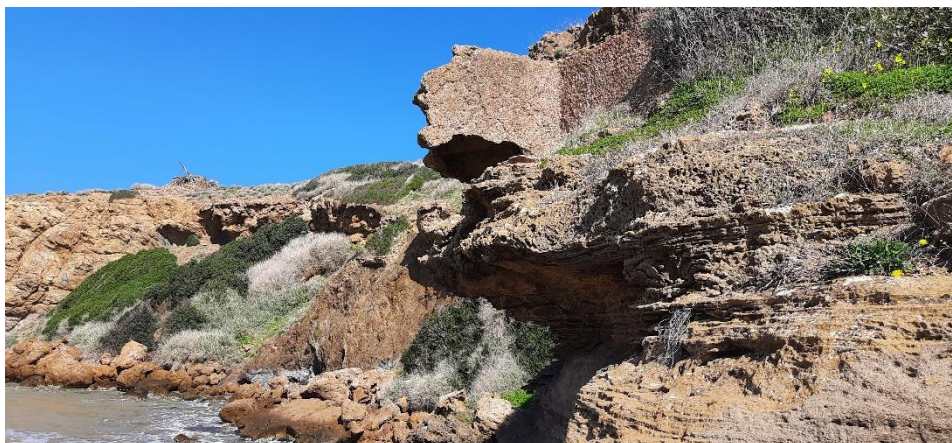
Fig.05 : Restes de réservoirs d'eau sur la falaise
