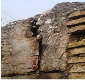
ج- تصدع الحجارة على مستوى جدار بالحمامات الكبرى
