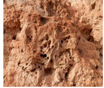
أ- تفتت حجارة التّوف لكهفي على مستوى جدار بالحمامات الكبرى
