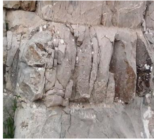
ب- تشقق الحجارة الكلسية المشكلة لقاعدة قوس كركلا
