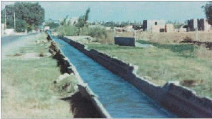
Cliché. 1 : Canal secondaire.
