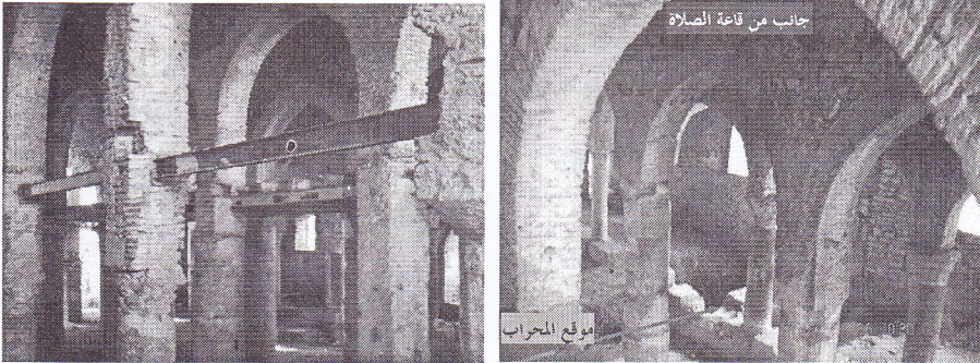
أعمدة وأقواس مبنية بالأجر وتبدو العوارض المعدنية الحاملة للطابق الأول المستحدث في العهد الاستعماري (صورة : 1-2) (ع/ل. وب)
