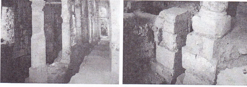
أسس رومانية شيدت عليها أعمدة المسجد (صورة: 3-4)
