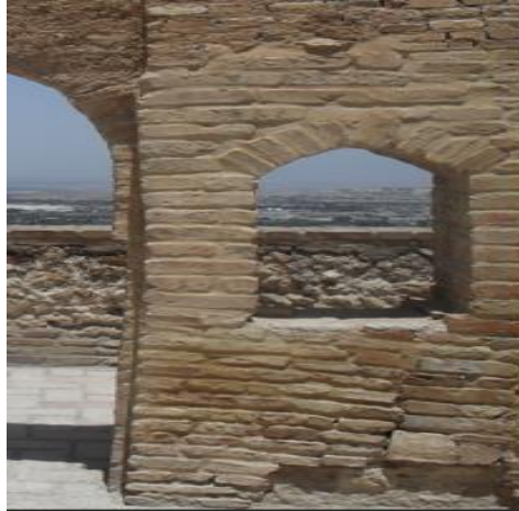
صورة رقم 1: تقنية نظام المداميك المزدوجة (من عمل الطالبة)
