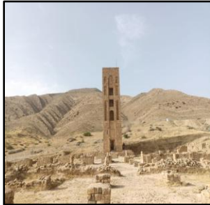
الصورة رقم 06: منظر شامل لمئذنة وبيت صلاة الجامع الأعظم. المصدر: إنجاز الباحث
