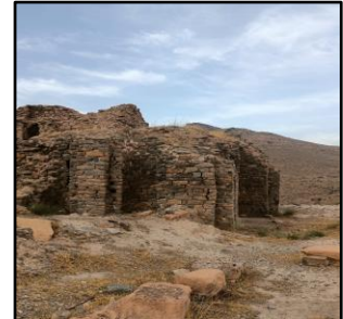
الصورة رقم 04: واجهة قصر المنار. المصدر: إنجاز الباحث
