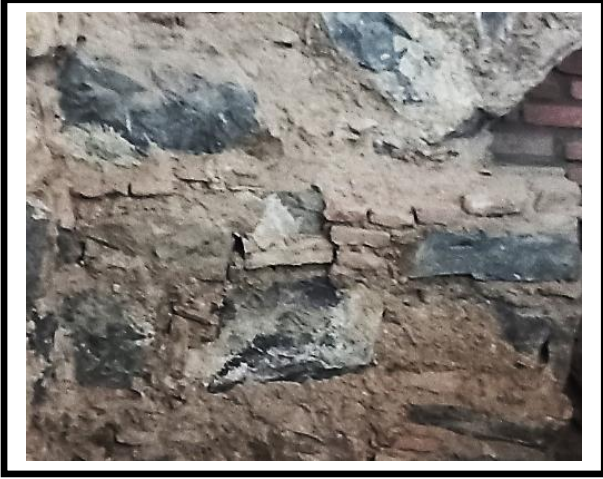
الصورة 13: تقنية المداميك المتكررة بالتناوب (تصوير الباحثين).
