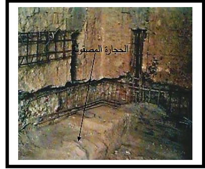
الصورة 09: استخدام الحجارة المصقولة في الاساسات (عن متحف برج موسى)
