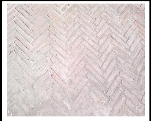
الصورة 15: تقنية السنبلة بأرضية الجامع ( عن جمعية المحافظة وترقية التراث الثقافي لمدينة بجاية )
