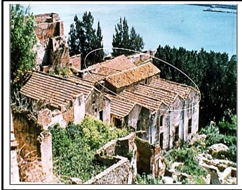
الصورة 08: السقف الجملوني بجامع القصبه (عن متحف برج موسى).
