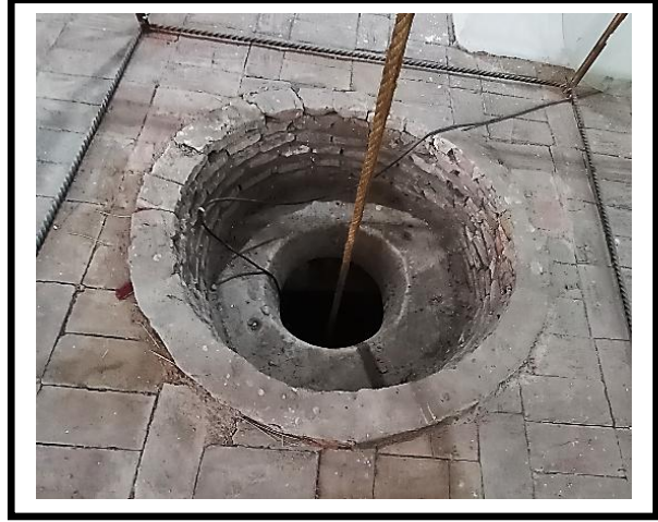
الصورة 12: تقنية المداميك المنتظمة بالآجر (تصوير الباحثين).
