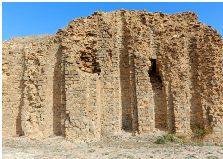
الصورة رقم 05 توضح الواجهة الجنوبية لبرج المنار
