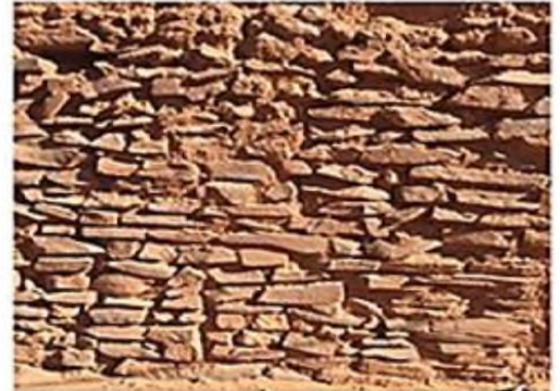
لوحة رقم (03) / طريقة المداميك العمودية المنتظمة
