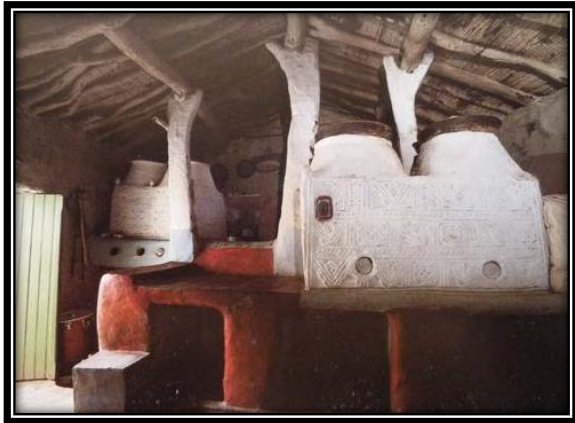
الصورة رقم 05: طريقة تدعيم السقف وتشكيل الحد الفاصل بين أجزاء قاعة المسكن
