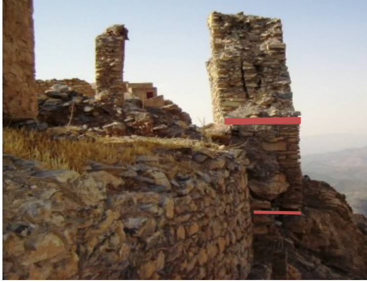
الصورة رقم (08): مستوى أرض التأسيس ونظام الجدران المضاعفة في نادي الضباط.
