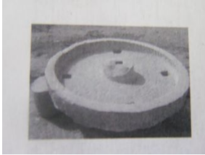
الصورة 09: حوض الطحن الطبقي الشكل الذي يحمل أربع قنوات صرف عند قاعدته. عن
