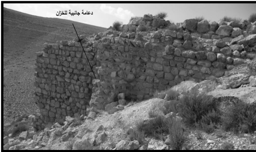
شكل رقم 12. دعامات الخزان الجانبية
