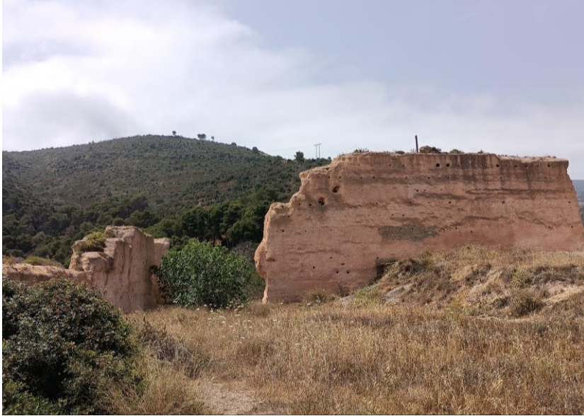
Figure 4 : Mur de séparation entre les deux parties
