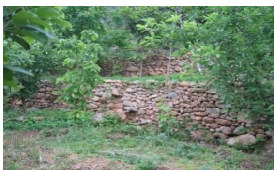
Photo n° 03 : Murets en pierre sèche
