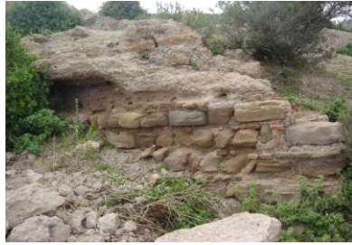
الصورة 02: طريقة بناء القسم السفلي من سور الطابية
