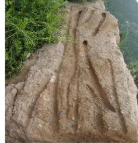
الصورة 04: آثار الأذرع الخشبية المثبتة في سور الطابية لتقويته
