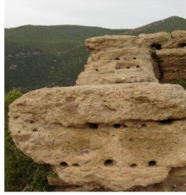
الصورة 04: آثار الأذرع الخشبية المثبتة في سور الطابية لتقويته
