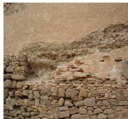
الصورة 06: طريقة ترميم سور الطابية
