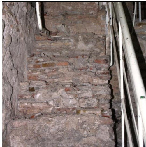
Fig. 11 - Escalier en maçonnerie de briques et paillasse en rondin de thuya, menant depuis le hall d'entrée à la chambre située au-dessus de la salle de prière.
