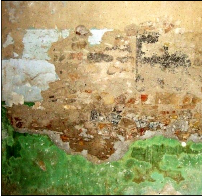
Fig. 13 - Mur nord décapé de la salle de prière : maçonnerie hybride, à double couche de revêtement, la plus ancienne à base de terre et la plus récente à base de ciment, couverte chacune de plusieurs couches de peinture.
