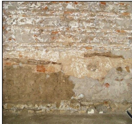
Fig. 8 - Mur est de la chambre au-dessus de la salle de prière : Soubassements en adobe avec placage de brique et chainage en rondin de thuya, et élévation en opus mixtum alternant une assise de pierre et deux assises de brique ; l'ensemble chaulé et couvert par une bonne couche de mortier à base de ciment.
