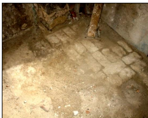
Fig. 15 - Sol de la salle de prière carrelé de briques posées sur un sol de préparation à base de chaux.
