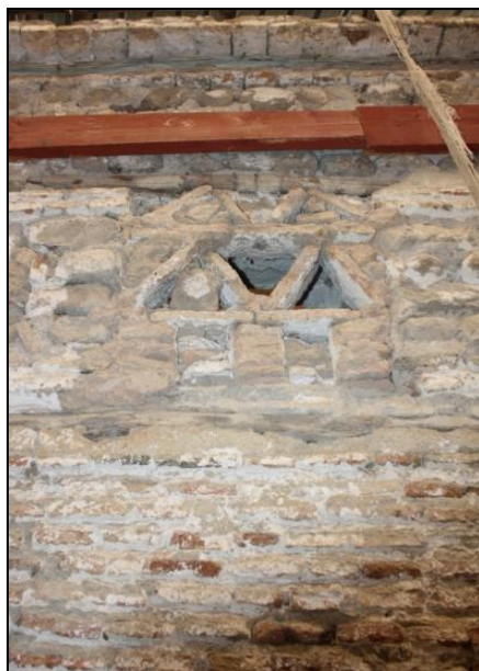
Fig. 20 - Fenêtre en brique découverte derrière le mur du mihrab.
