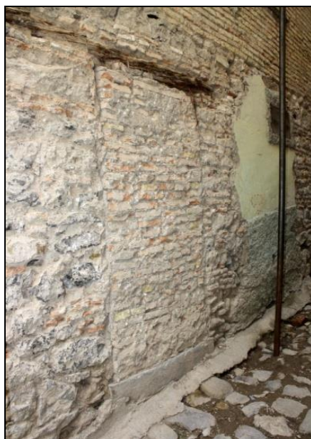
Fig. 19 - Porte fermée en maçonnerie de brique, réalisée dans le mur est de la salle d'ablution.
