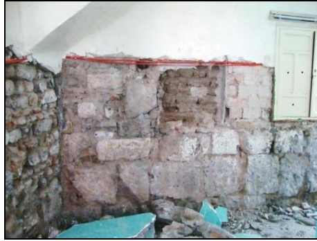
Fig. 7 - Murs de la salle de prière. En face, le mur ouest : soubassements appareillé et élévation en opus mixtum et adobe avec placage de brique ; Côté gauche : le mur sud construit en maçonnerie de pierre et chainage de brique.
