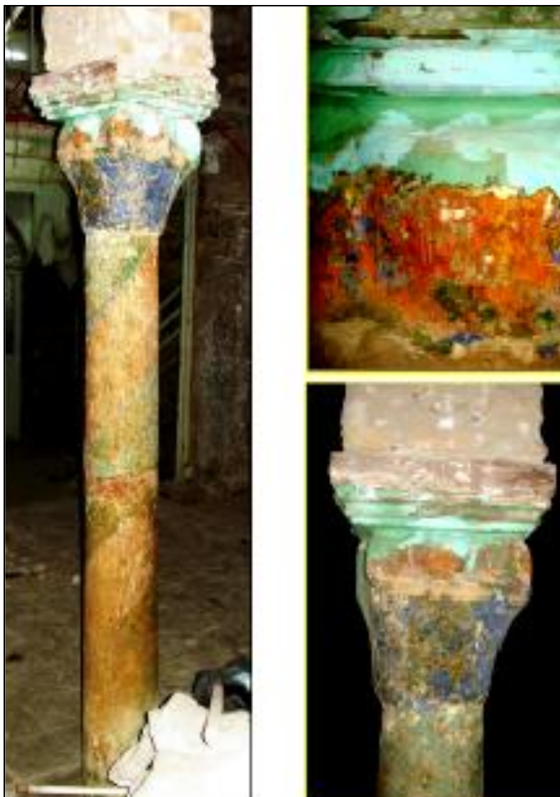
Fig. 14 - Colonne de la salle de prière à chapiteau hafside, couvert de plusieurs couche de peinture, et fut à peinture torsadée.
