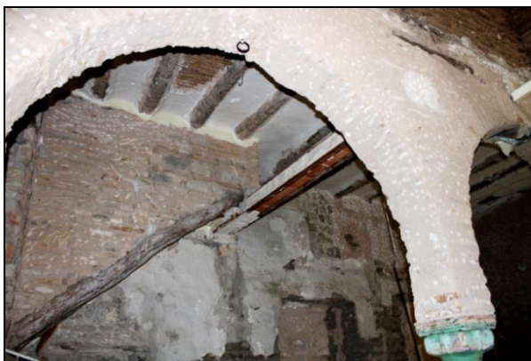
Fig. 21 – La salle de prière : Escalier en maçonnerie, à pailleasse en rondin de thuya, appuyé à l'étage sur une poutre métallique fourrée de briques.
