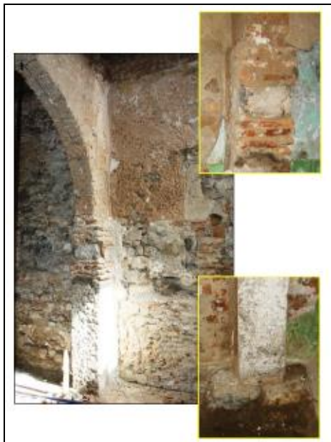
Fig. 9 - Mur ouest de la salle de prière : pilier d'arc construit en bloc de pierre de taille et brique de terre cuite, posé sur des fondations en pierre.
