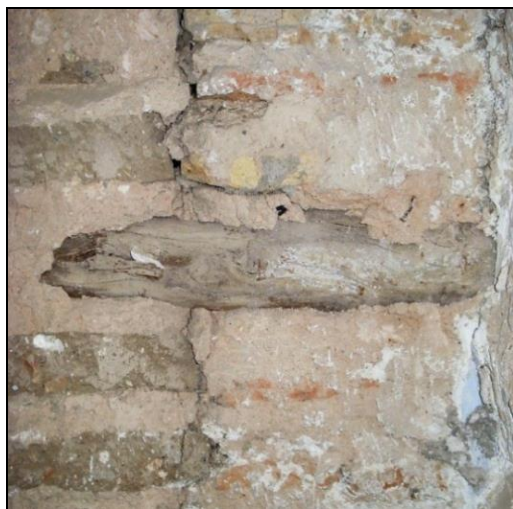
Fig. 12 - Mur en maçonnerie de briques crues, avec chainage d'angle en briques de terre cuite et rondins de thuya.
