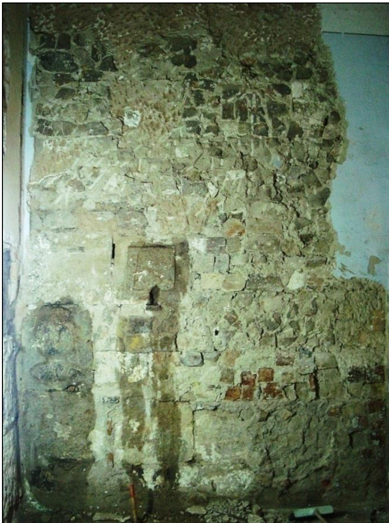
Fig. 6 - Mur nord de la salle de prière à soubassements appareillés et placage de brique.
