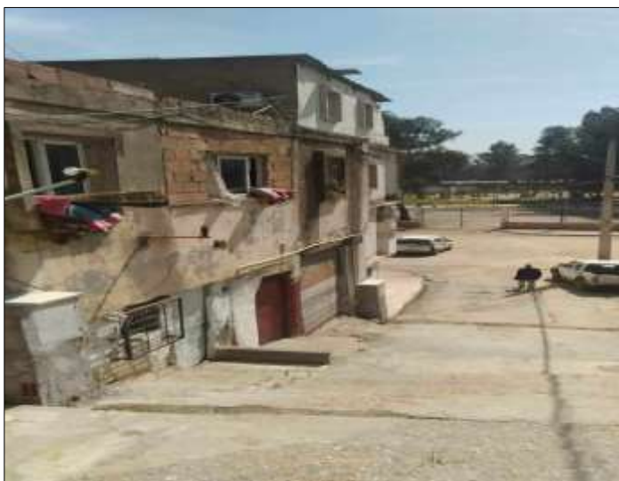
Figure 9 : Photo d'habitations situées dans le centre de la strate 06
