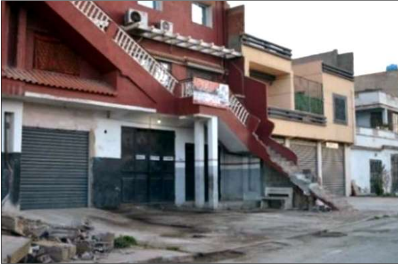
Photo 2 : Démolition de l'extension illégale des escaliers d'une habitation individuelle
