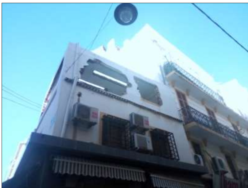
Photo 5 : Une surélévation illicite d'un immeuble commercial rue Didouche Mourad (détruite depuis)
