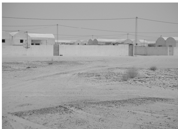
Photo 1 : Village d'El Ferdaous à Régim Maâtoug (Photo. A. Daoud 2008)
