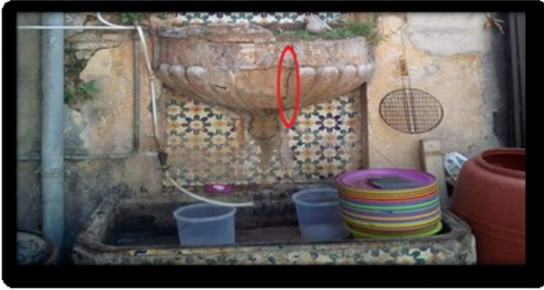
الصورة رقم 11: الأجر مستخدم في بناء جدران الفندق. الصورة رقم 12: شقوق موجودة على مستوى الفسقية. (من تصوير الباحثة) (من تصوير الباحثة)
