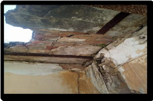
الصورة رقم 22: الإضافات الحديثة بالفندق. الصورة رقم 23: سقوط سقف غرفة. (من تصوير الباحثة) (من تصوير الباحثة)
