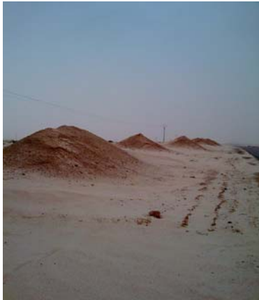
Photo. 3. Tas des remblais orientés obliquement
